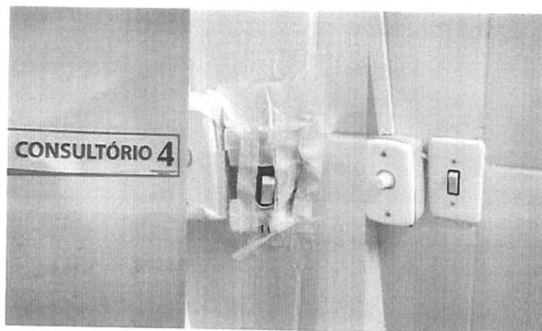
Fig. 20 – Substituição de 01 interruptor.
