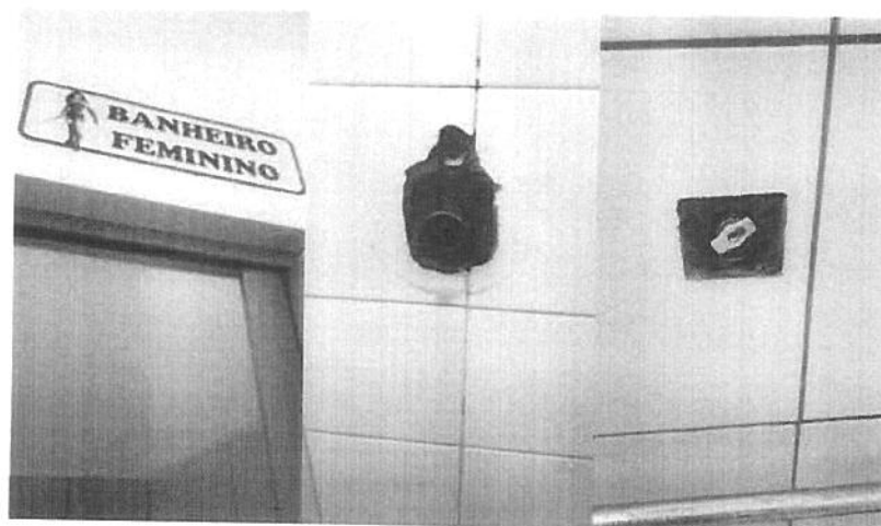
Fig.19 - Substituição do reparo da válvula de descarga.
