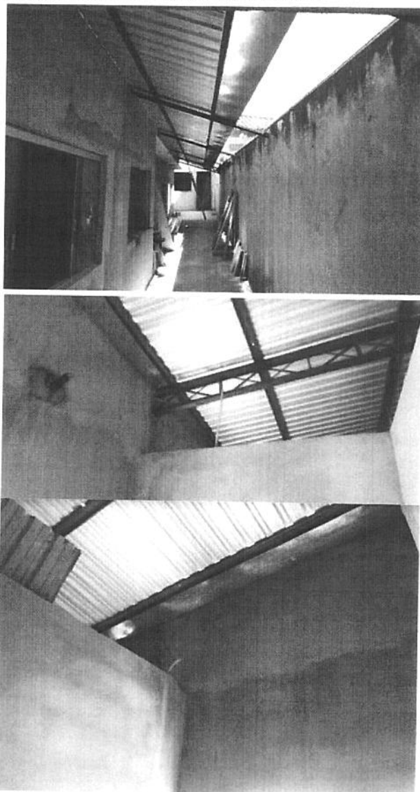
Fig. 2 - Instalação das calhas
