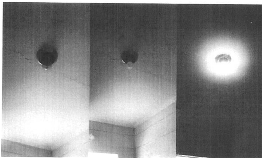
Fig. 15 - Substituição de lâmpada.
