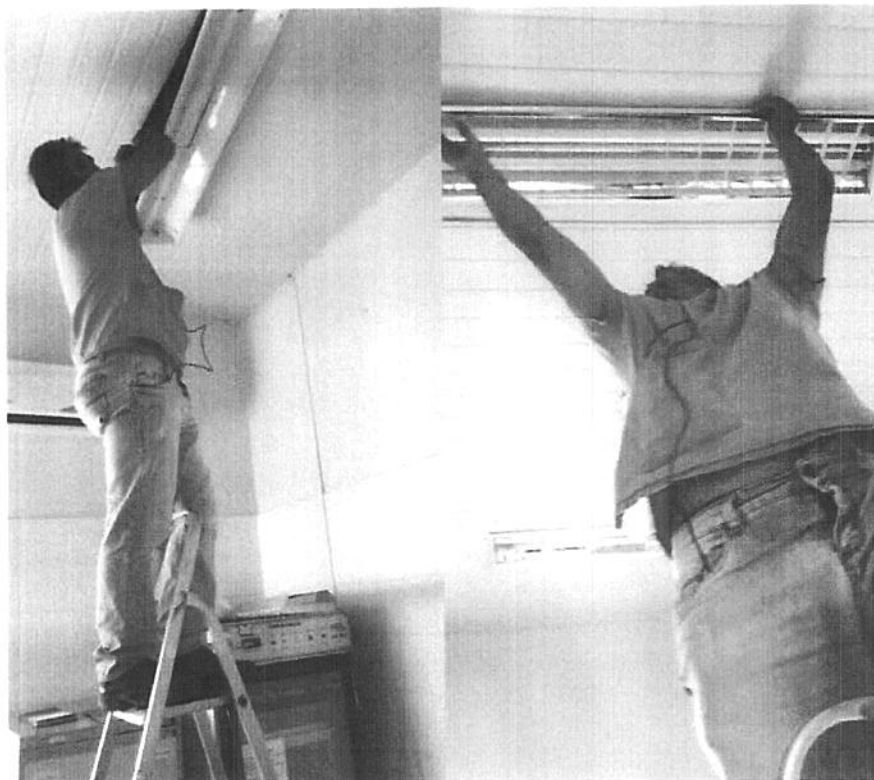
Fig.1 – Substituição de lâmpadas | UBS 03.
