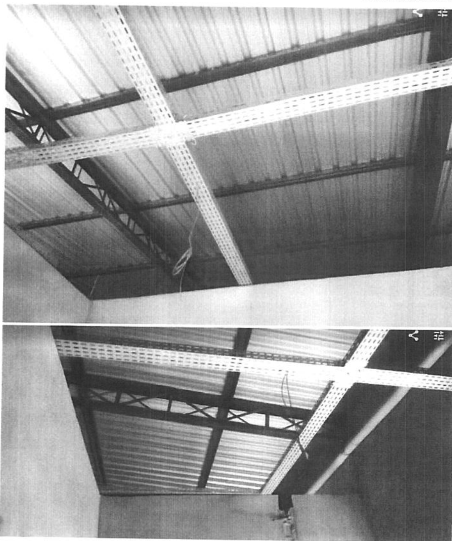
Fig. 4 – Instalação das esteiras para passagem dos cabos.
