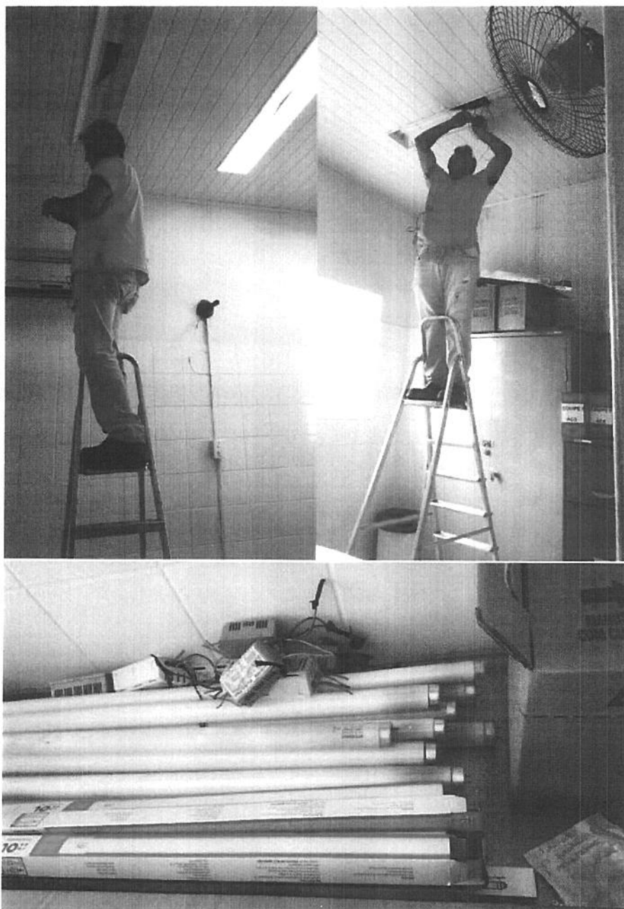
Fig.2 – Substituição de lâmpadas| UBS 03.
