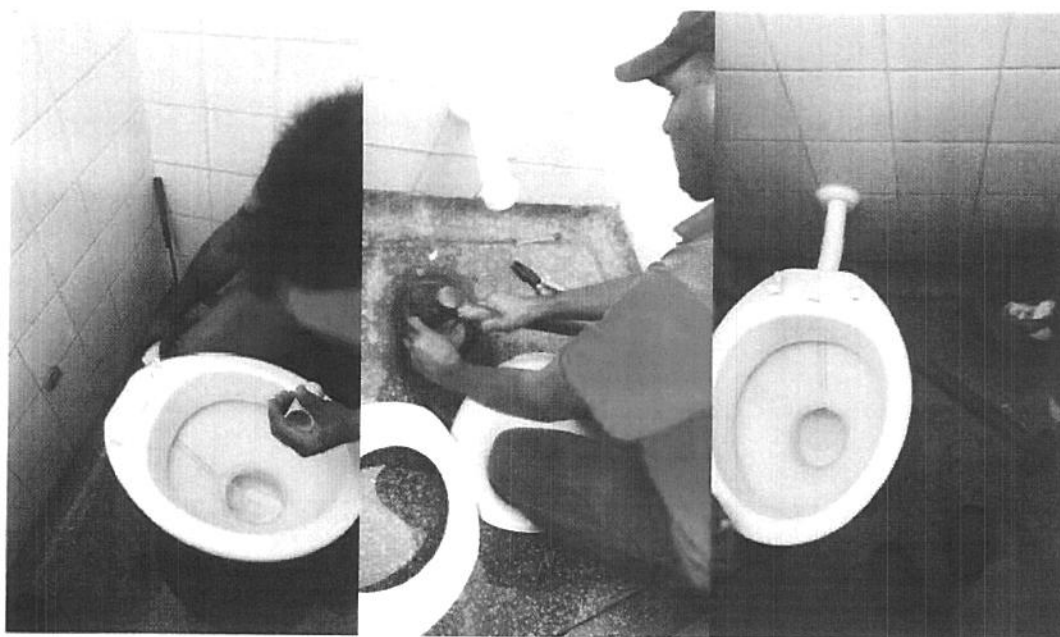
Fig. 3 – Substituição do tubo de ligação | Banheiro.
