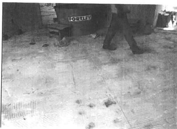
Fig. 7 - Remoção do revestimento cerâmico da sala de espera.
